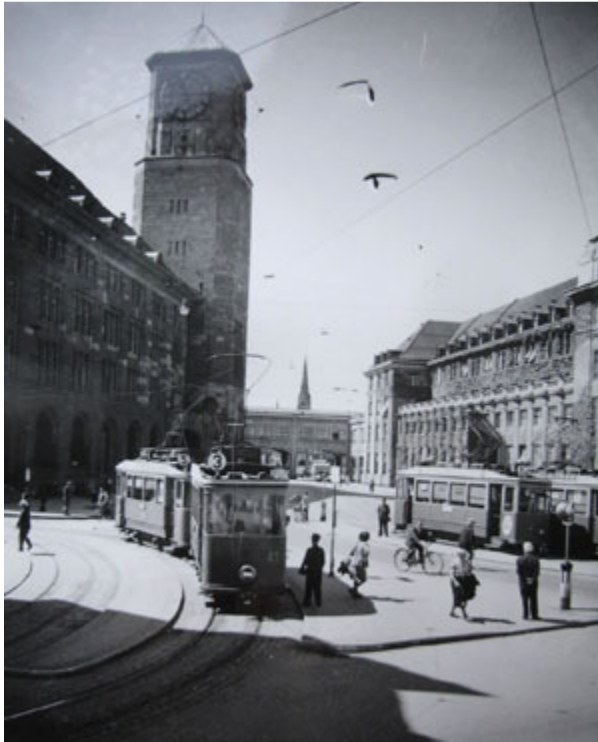
Ehemalige Traminsel mit Haltestelle, Bahnhofplatz, 9000 St. Gallen
