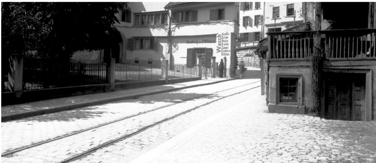
Ehem. Tramhaltestelle an der Goliathgasse, 9000 St. Gallen (um 1900).
